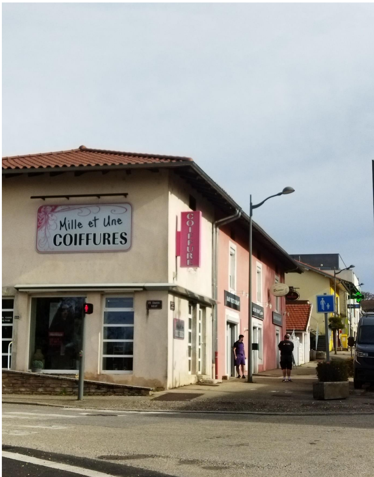
Commerces en pied d'immeuble.
